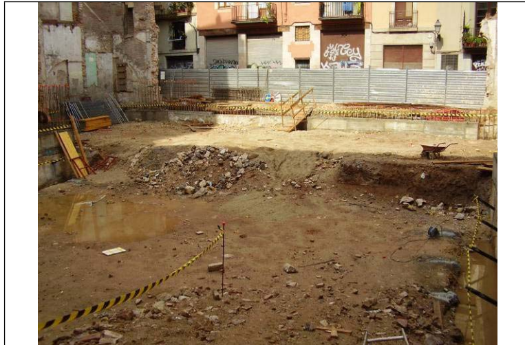
Foto núm.1 Vista general del solar abans de l'excavació
