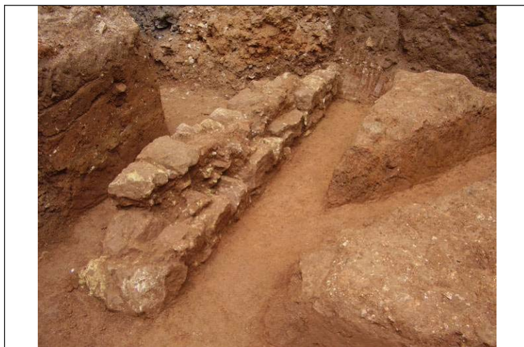
Foto núm.8 Sector nordest, mur UE 1053
