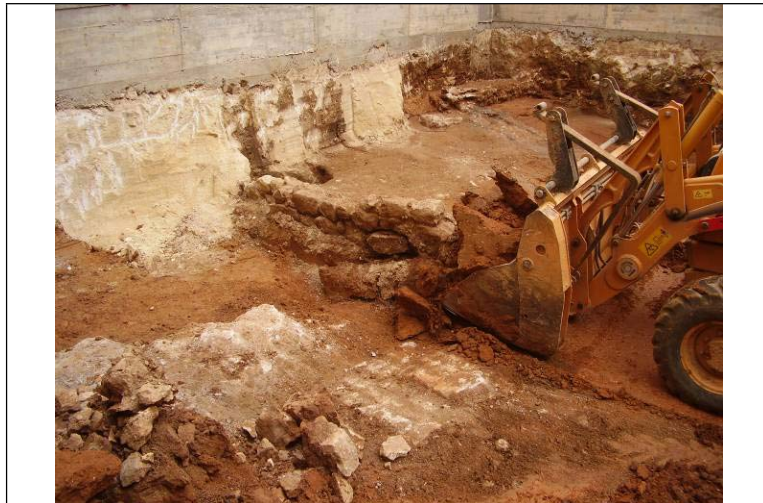
Foto núm.31 Sector nordest, enderroc del mur UE 1053
