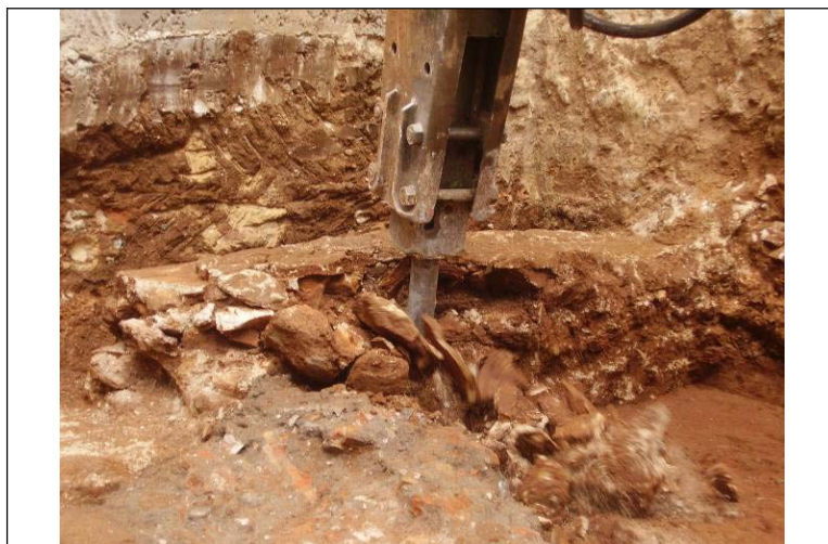
Foto núm. 32 Sector nordest, enderroc del mur UE 1095
