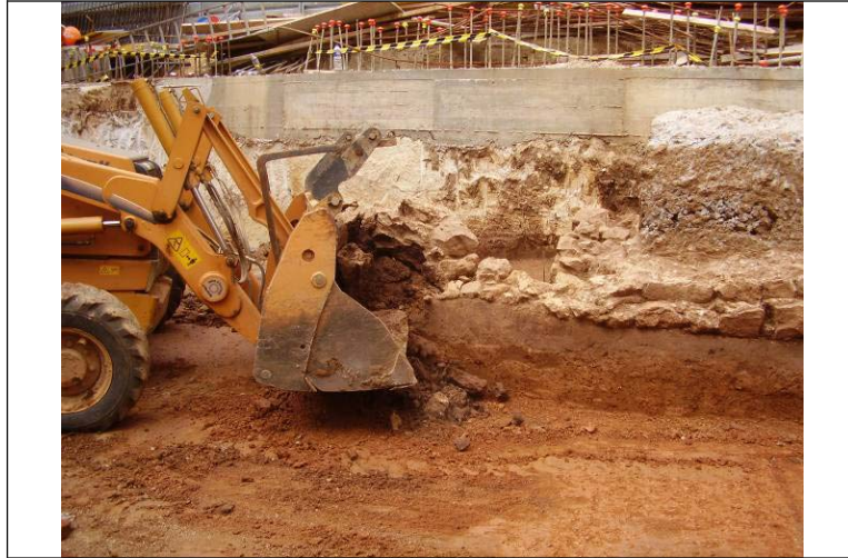
Foto núm.30 Sector central, enderroc del mur UE 1035
